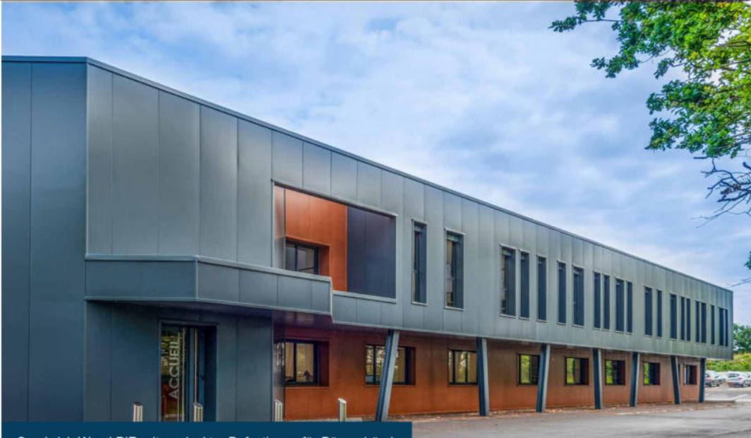
Sandwich Wand PIR mit verdeckter Befestigung für Bürogebäude
