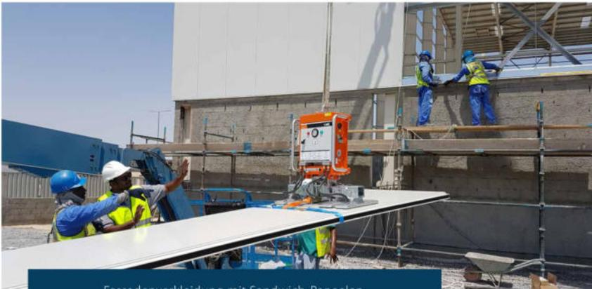
Fassadenverkleidung mit Sandwich-Paneeelen.
